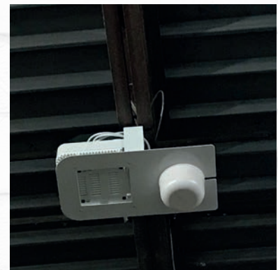
Kombihalterung für Access Point und WLAN Antenne an einer Hallendecke
